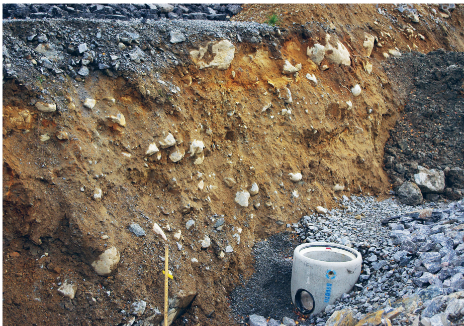
Figur 3: Det är uppenbart att faktorer som jordegenskaper och jordlagrens uppbyggnad påverkar schaktbarheten (grävbarheten).
