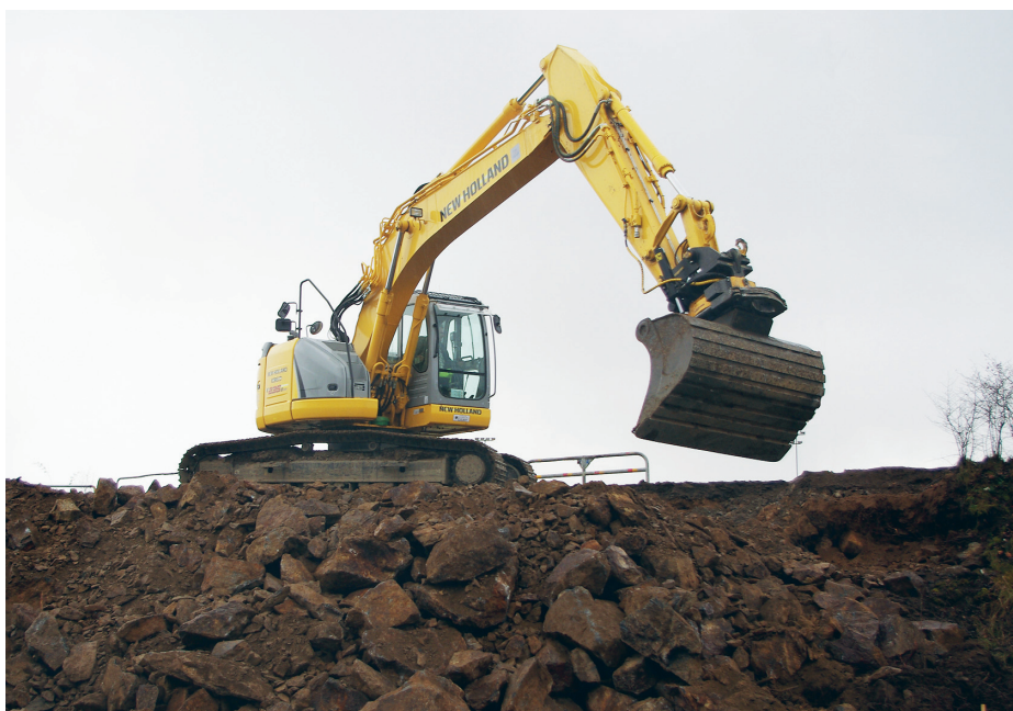
Figur 2: Schaktning i morän och fasta friktionsjordar utförs idag med helt andra maskiner än på 1970-talet. Bilden visar en kraftfull maskin som används vid schaktning i fasta friktionsjordar.
